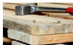
Einschlagen herausstehender Befestigungselemente
